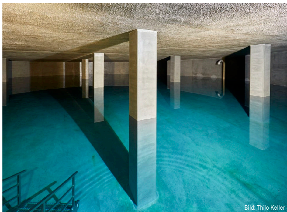
Blick in die Behälterkammer
