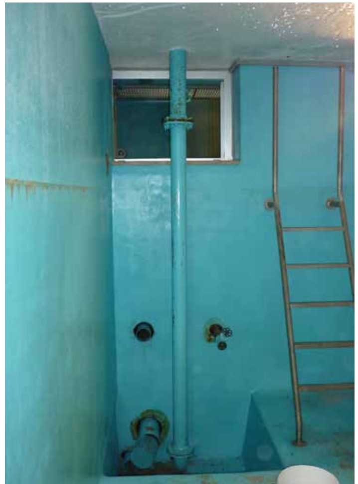
Rohwasserkammern nachher/ vorher
